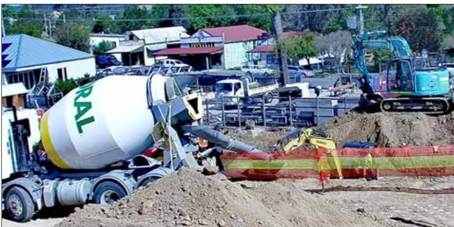
Concrete pour at Market Hall site
